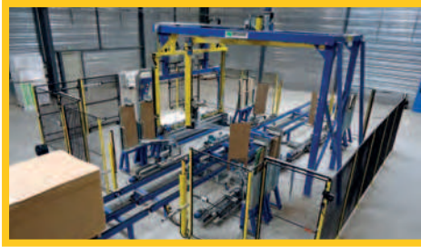
Clôtures de sécurité Safety perimeter fencing
